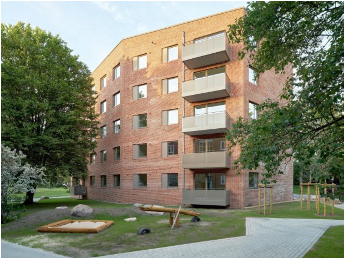
Ebenfalls preisgekrönt: Wohnen am Kiwitteemoor-Park Foto: tun-architektur
