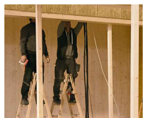
Gezimmert. Am Standort im Industriepark in Köpenick entstehen die Module.
